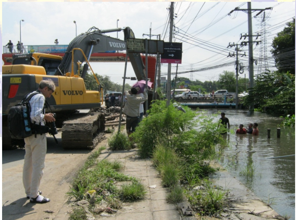
ภาพถ่ายแสดง การอุดท่อลอด บริเวณหน้าการประปา ถนนสามัคคี
