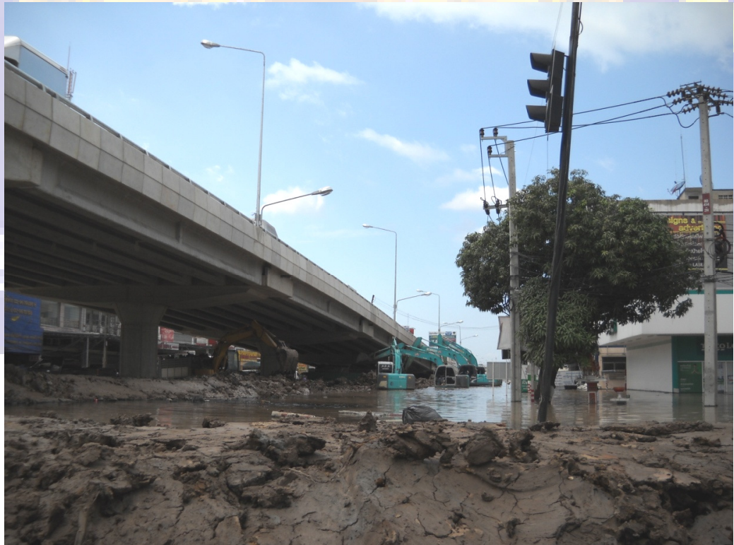
ภาพถ่ายแสดง การปั้นแนวคันดินบริเวณแยกสะพานนทบุรี(สะพานนวลฉวี)
