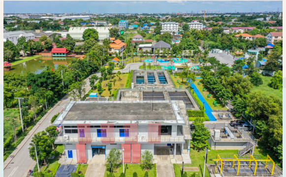
โรงปรับปรุงคุณภาพน้ำ เทศบาลนครปากเกร็ด
